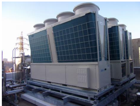
(改修後) 冷温水チラー（高効率型）
