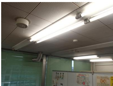
写真1. 不要箇所の照明間引き
